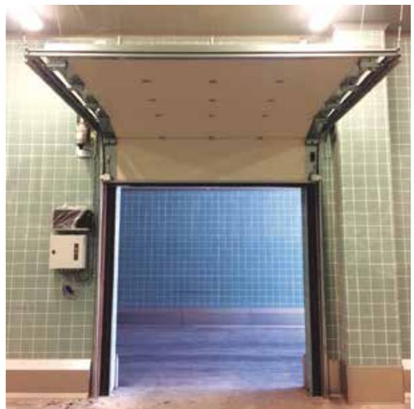
**Funcionamiento:** el sistema se compone de dos soportes de acero galvanizado sobre el cual está montado el eje. Los soportes se sujetan a la pared con pernos y placas de anclaje. El eje de transmisión, ubicado entre los soportes, está equipado con dos tambores de aluminio que unen los cables de acero a la hoja de la puerta. El conjunto está asegurado por un mecanismo de protección contra la rotura de cable.
