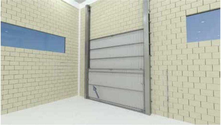
**1.4** Valiéndose de la pértiga, llevar la puerta hasta el final del recorrido para que llegue a contactar con los topes superiores de las guías.
